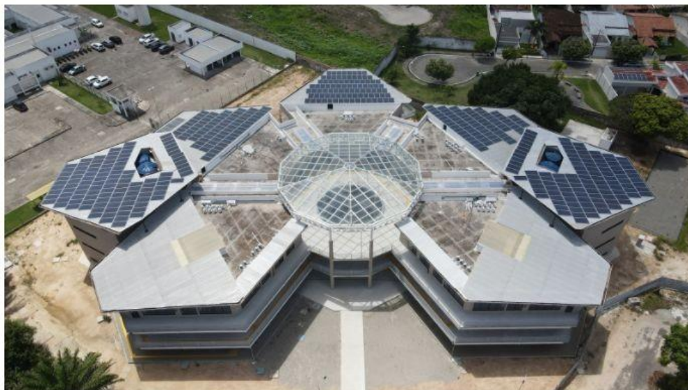
Imagem 6: Núcleo Pedagógico do Campus Paulo Freire (em construção)
