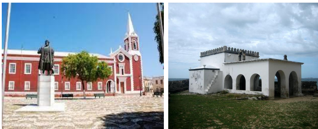
Figura 9: Imagem da Torre de São Gabriel (actual Museu) à esquerda e Capela da Nossa Senhora de Baluarte a direita.
