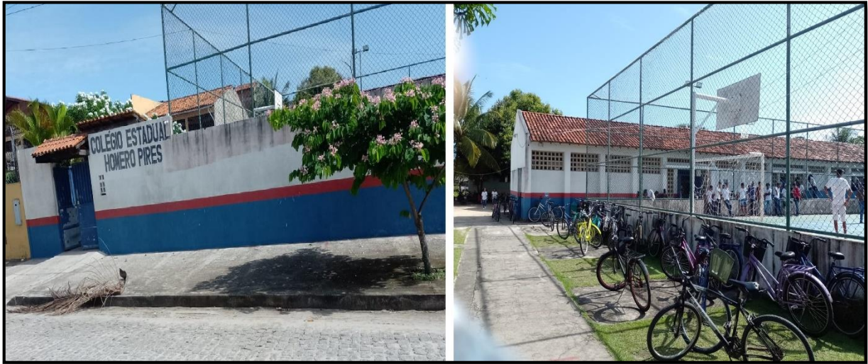
Figura 5: Montagem de imagens da fachada e entrada do Colégio Estadual Homero Pires.
